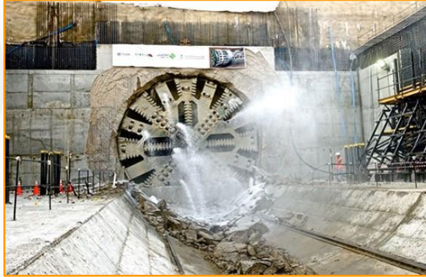
Instalaciones electromecánicas líneas 4,5 y 6 Metro Riad: 179 Mn€
