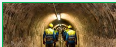
Mantenimiento del alcantarillado
