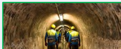
Mantenimiento del alcantarillado
