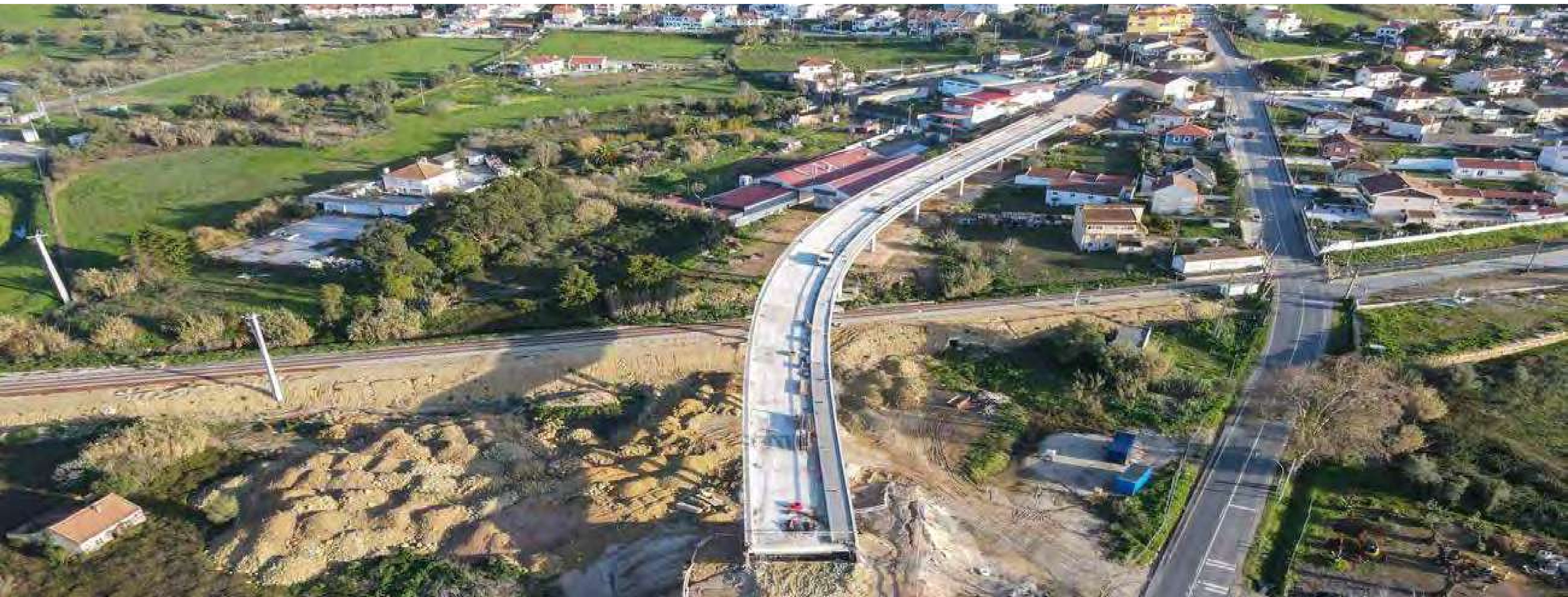
Tramos ferroviarios, Portugal
