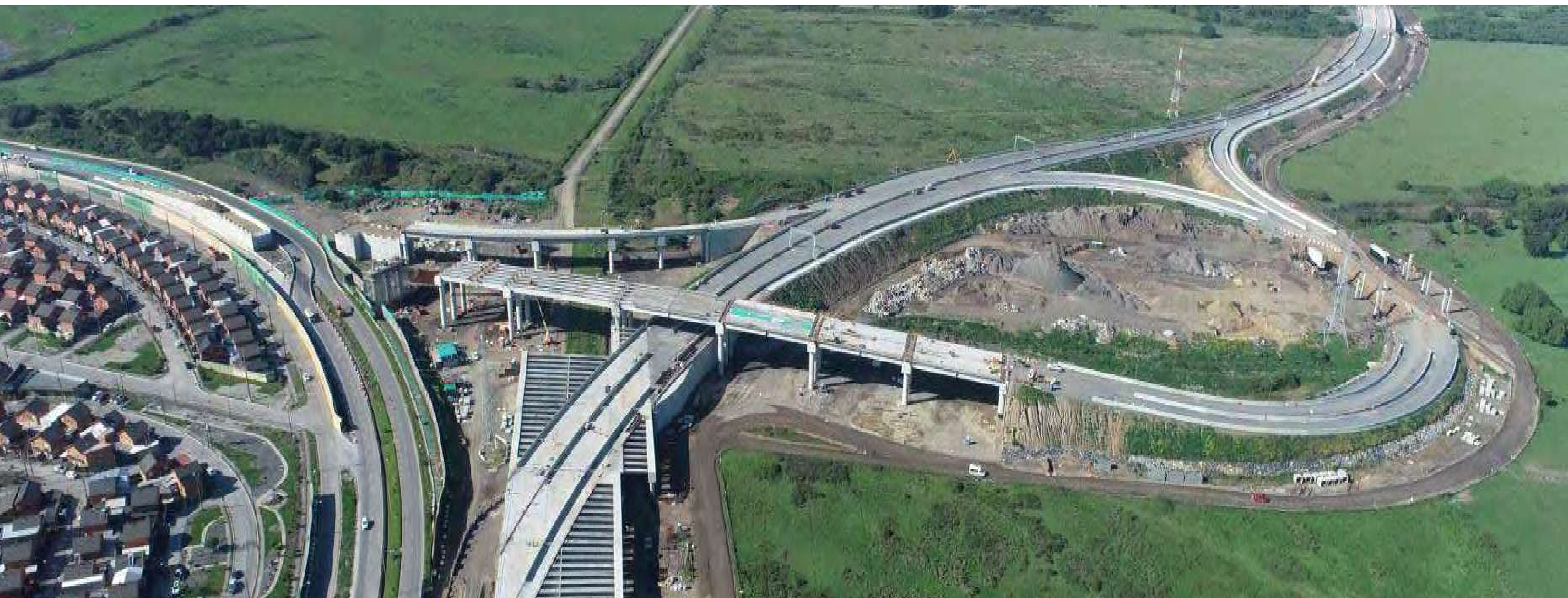
Puente Industrial, Chile
