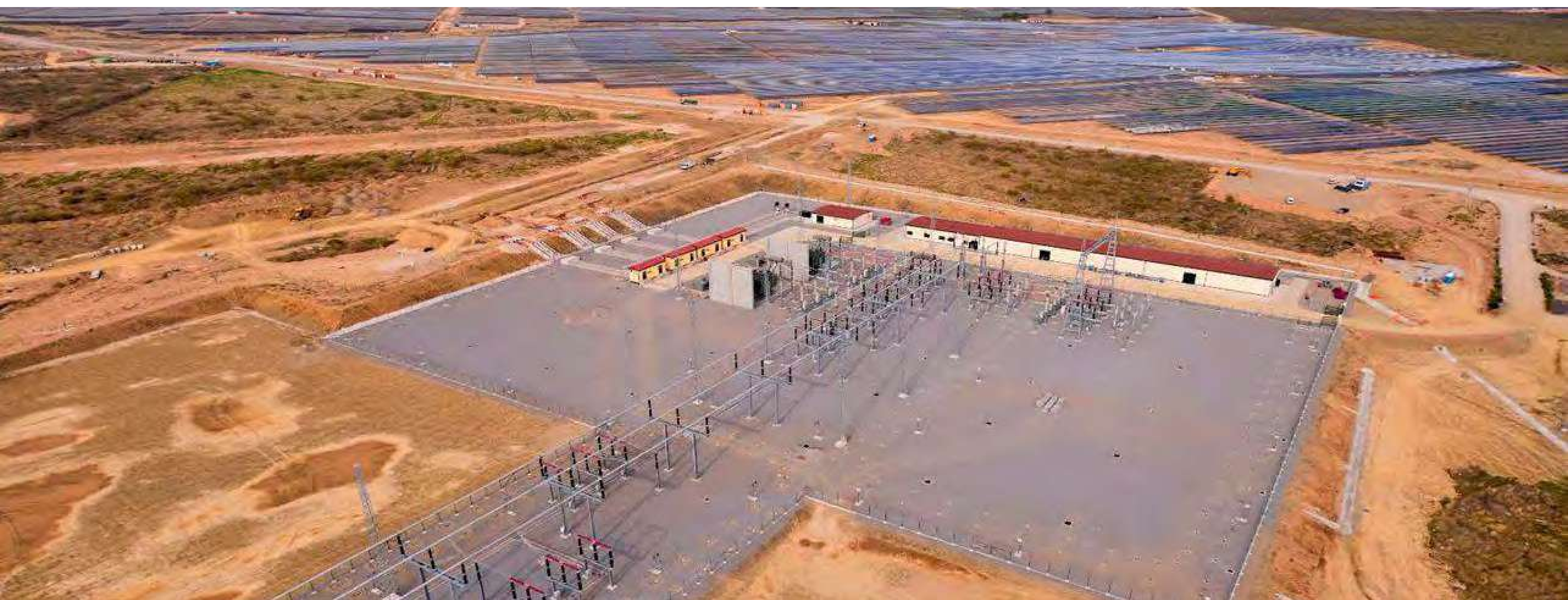
Planta fotovoltaica Pizarro, España
