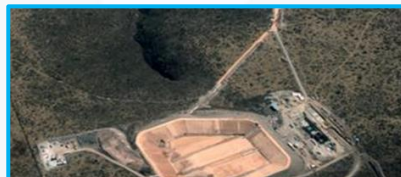
Diseño, Construcción y Financiación de Infraestructuras hidráulicas
