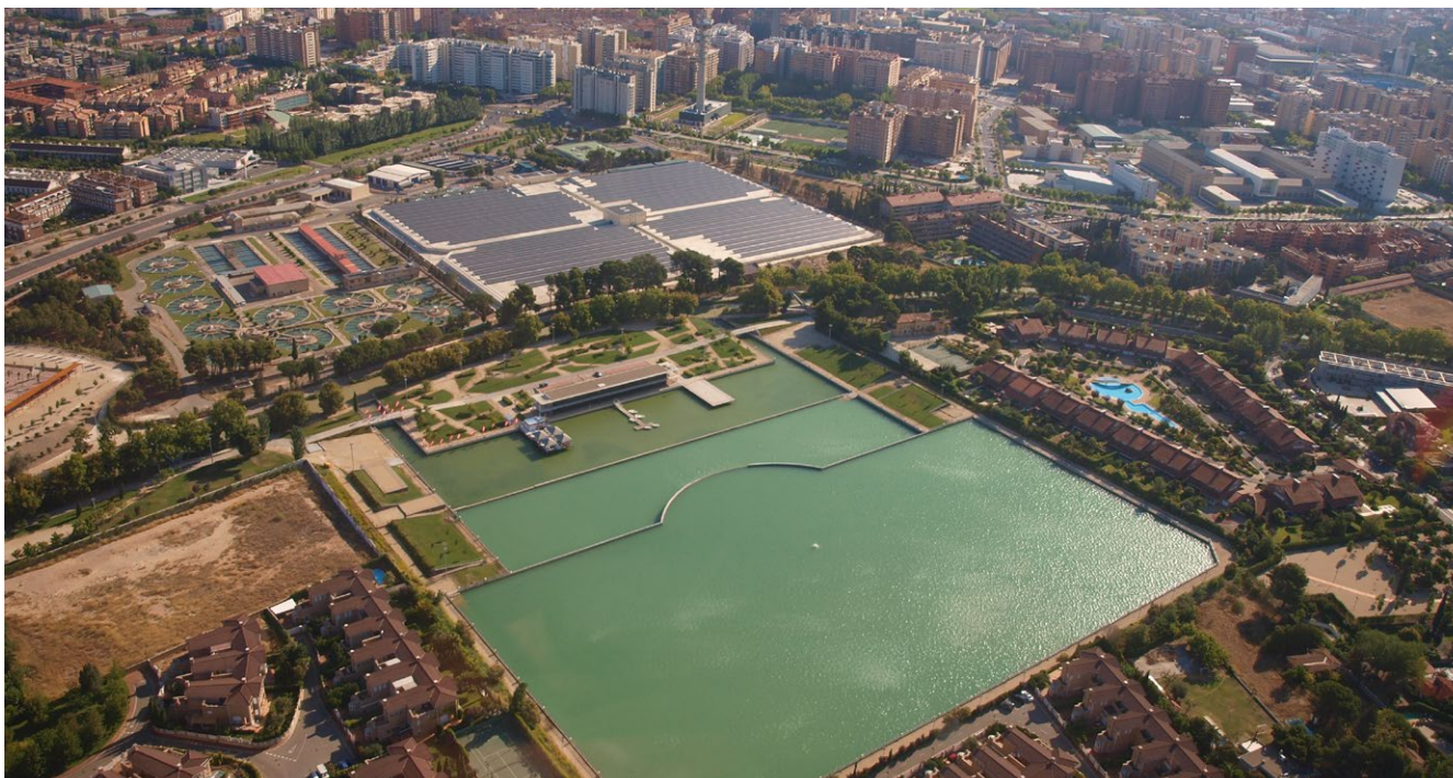
Depósitos de agua de Casablanca, Zaragoza. España
