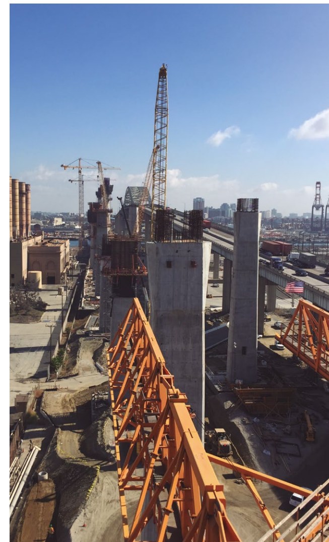
Puente Gerald Desmond, Los Ángeles (Estados Unidos)
