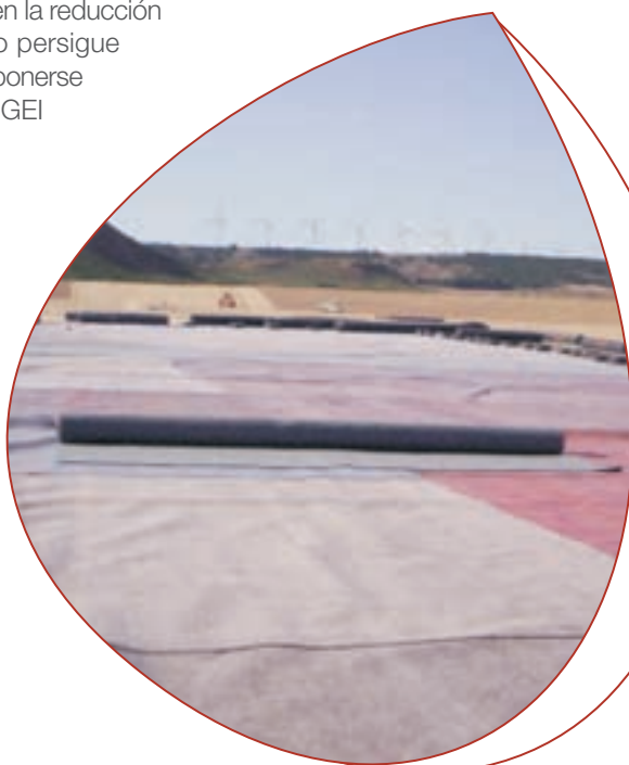
Impermeabilización de vaso de vertido del vertedero de “El Culebrete” (Tudela, Navarra)
