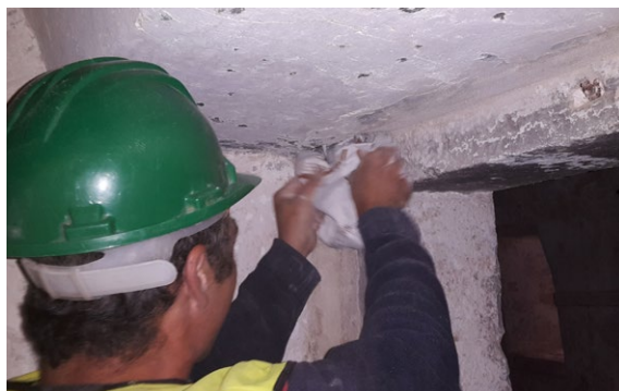
Trabajos de exclusión de los murciélagos.
