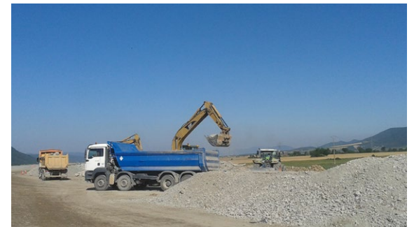
Recogida del material de desecho preparado para la obra.
