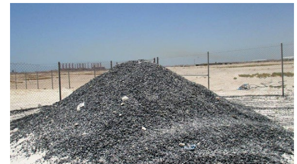
Material de demolición depositado en el área de seguridad.
