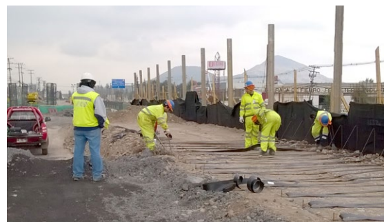
Uso de escoria de acería en el núcleo del terraplén para uno de los muros.
