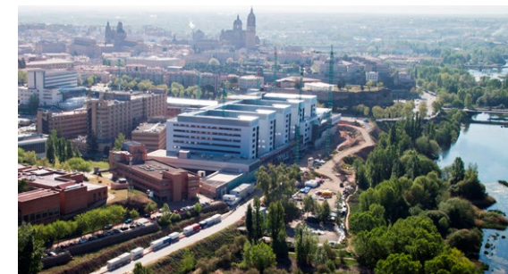
Zona antes y después de la actuación.
