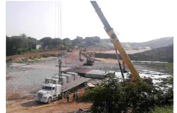
Colocación de cajones prefabricados en el interior de las lagunas con la finalidad de dar continuidad al agua y a las especies acuáticas.
