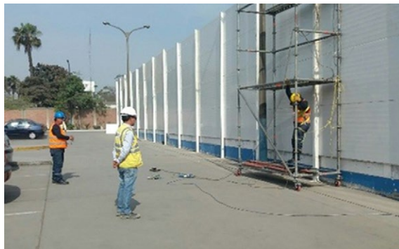
Vista de los paneles desde el interior del Hospital Jorge Voto Bernales.
