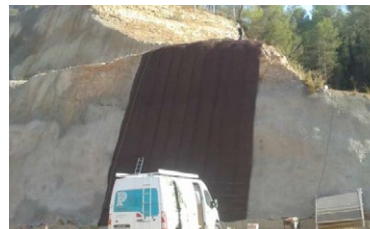
Sección del talud de prueba.
