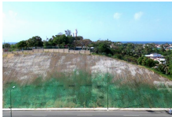
Hidrosiembra sobre los laterales del terraplén.
