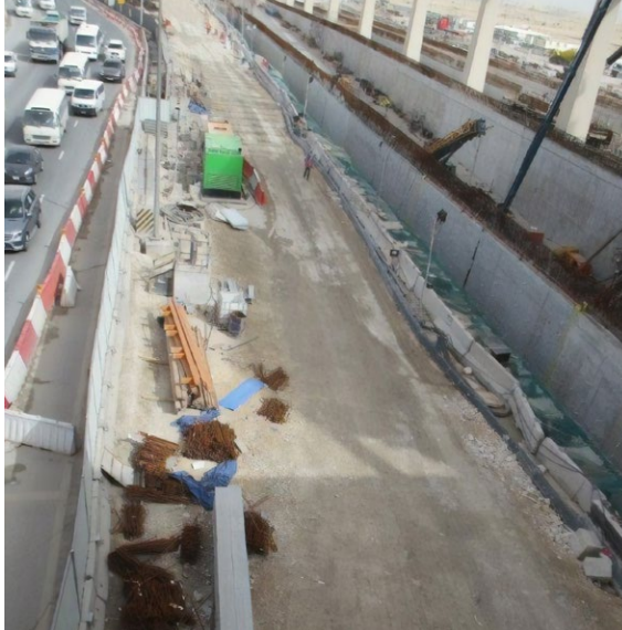
Construcción del paso inferior de la autopista en la zona norte del proyecto.
