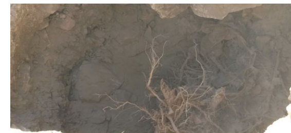
Eliminación de tocones, raíces y tierra circundante.
