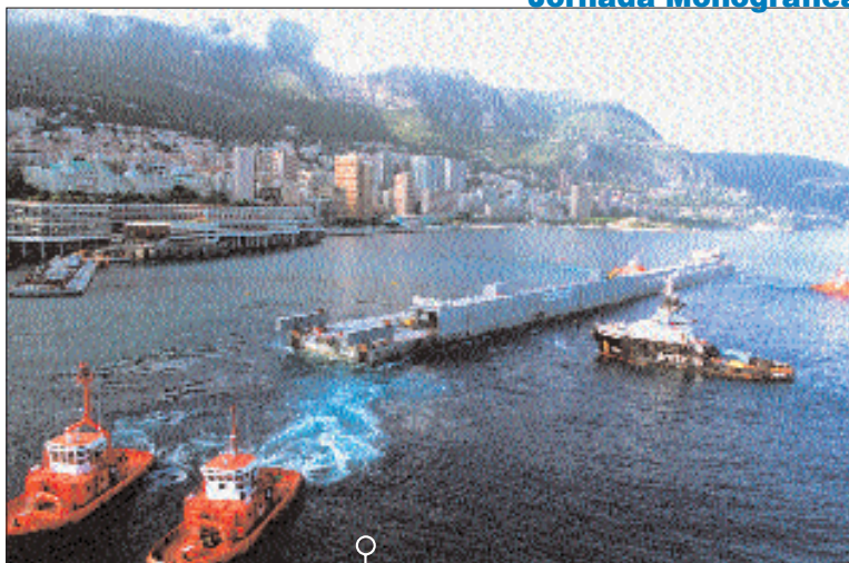
LLEGADA DEL DIQUE a la bocana del puerto del Principado de Mónaco.
