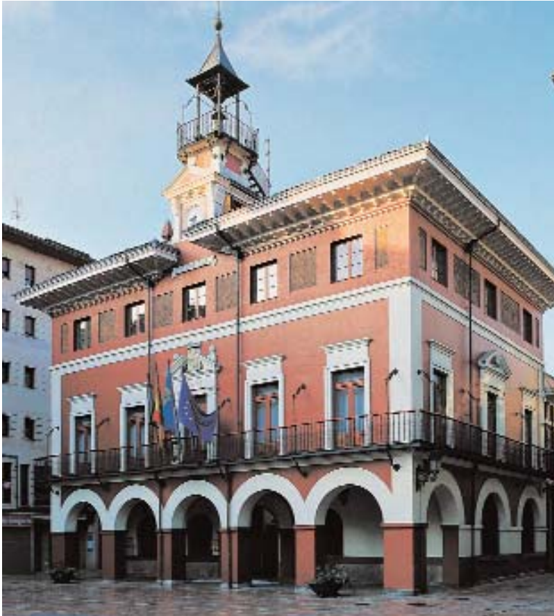
FACHADA DEL AYUNTAMIENTO de Langreo y refrigerante de Valnalón, sede del Museo de la Siderurgia.
