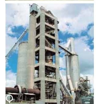
ARRIBA, FÁBRICA DE ELS MONJOS en Barcelona, y abajo, planta cementera de Minas, en Uruguay.
