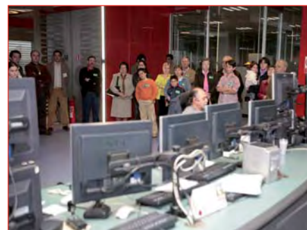
Sala de control.
