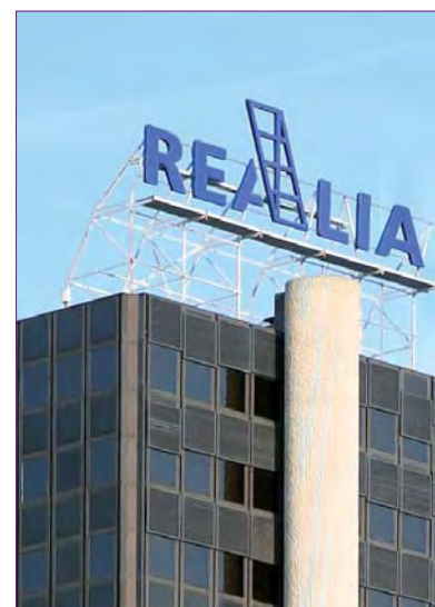
Sobre estas líneas y a la izquierda, el Edificio de Los Cubos, propiedad de Realia, situado en la M-30 de Madrid.
