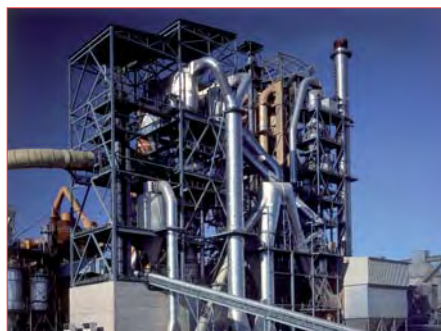
Detalle de la fábrica.
