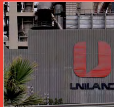
A la izquierda y sobre estas líneas, fábrica de hormigón de Vallcarca, en Barcelona.
