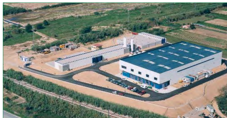
En la imagen la desaladora de La Tordera, ubicada en el término municipal de Blanes (Girona).
