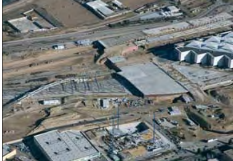
Vista aérea de las obras del entorno de la Estación Intermodal de Delicias, en Zaragoza.
