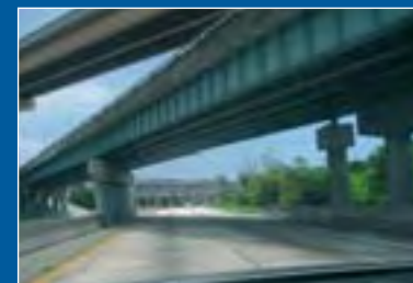
Detalle de los dos overflights curvos, viaductos de tercer nivel, situados en el Intercambio SR-112, a la derecha.
