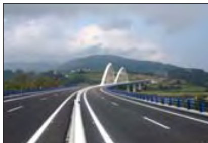
Arriba, el viaducto de Canero que forma parte de la actuación de la Autovía del Cantábrico, correspondiente al tramo Querúas-Otur. Sobre estas líneas, detalle de la variante de Navia.
