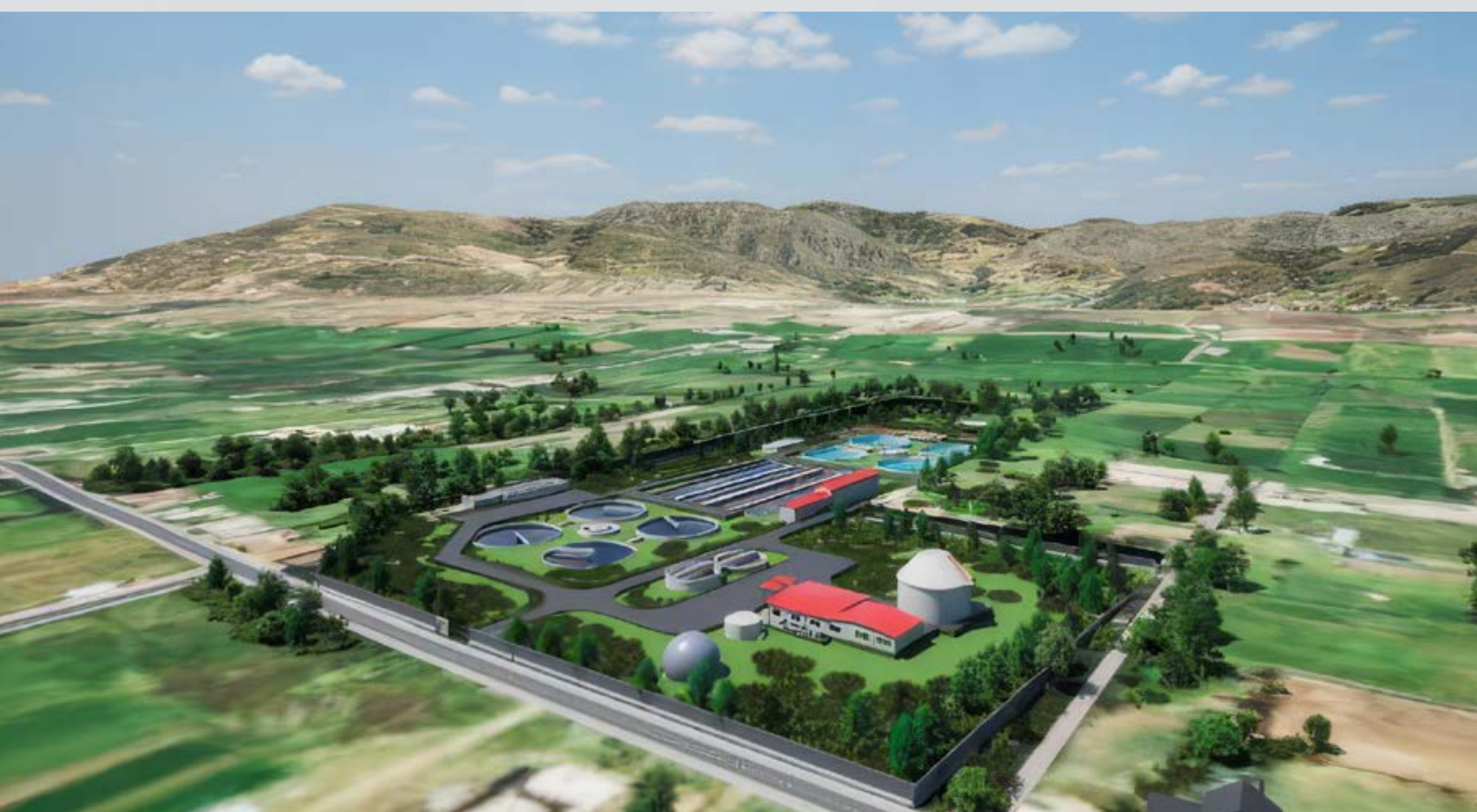
Recreación virtual de la Planta de Tratamiento de Aguas Residuales (PTAR) de Cajamarca (Perú), construida y operada por Aqualia. Abajo panorámica de la ciudad.
