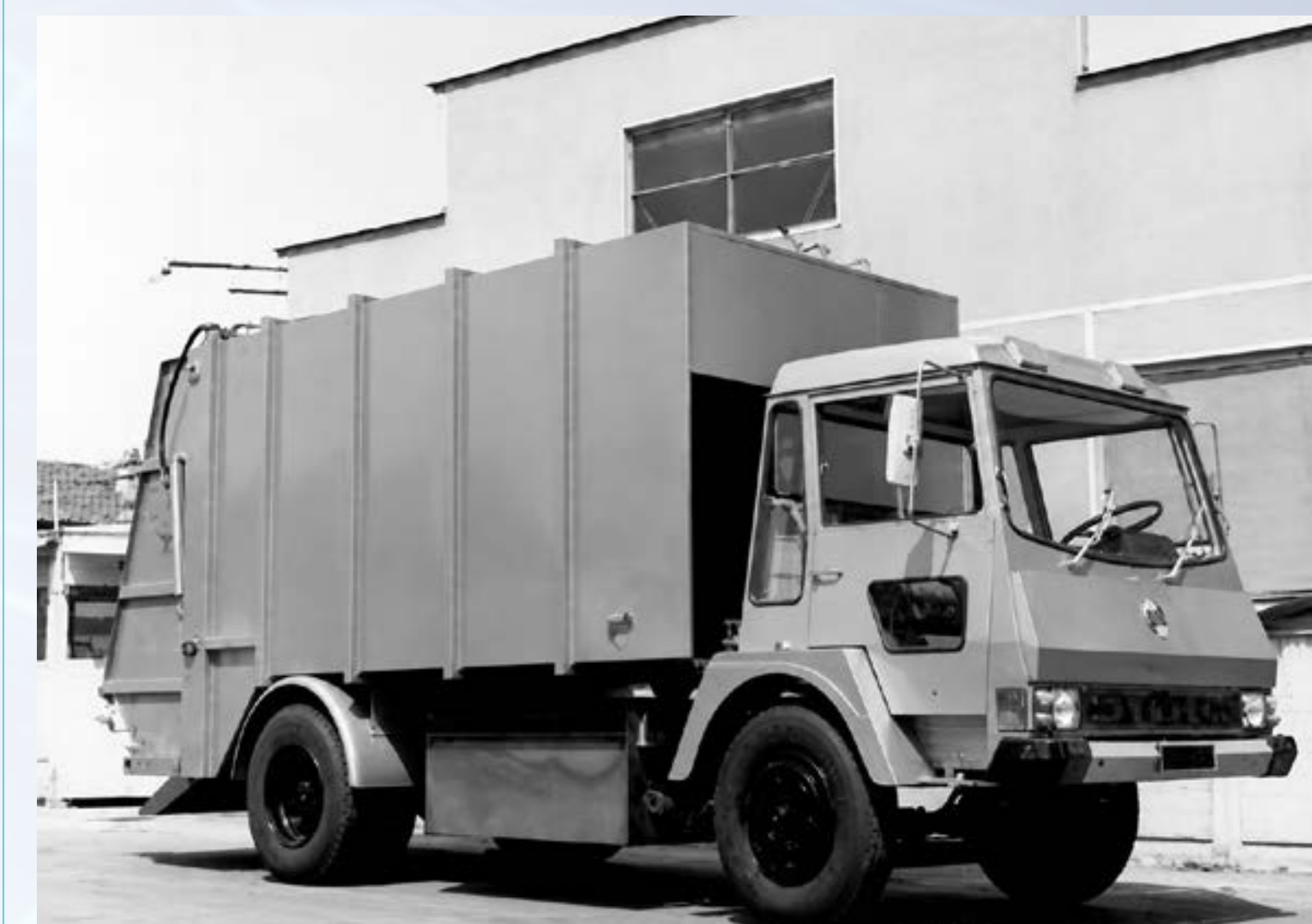
Primer vehículo recolector eléctrico de FCC Medio Ambiente, incorporado en Barcelona en 1974 y equipado con baterías de plomo.
