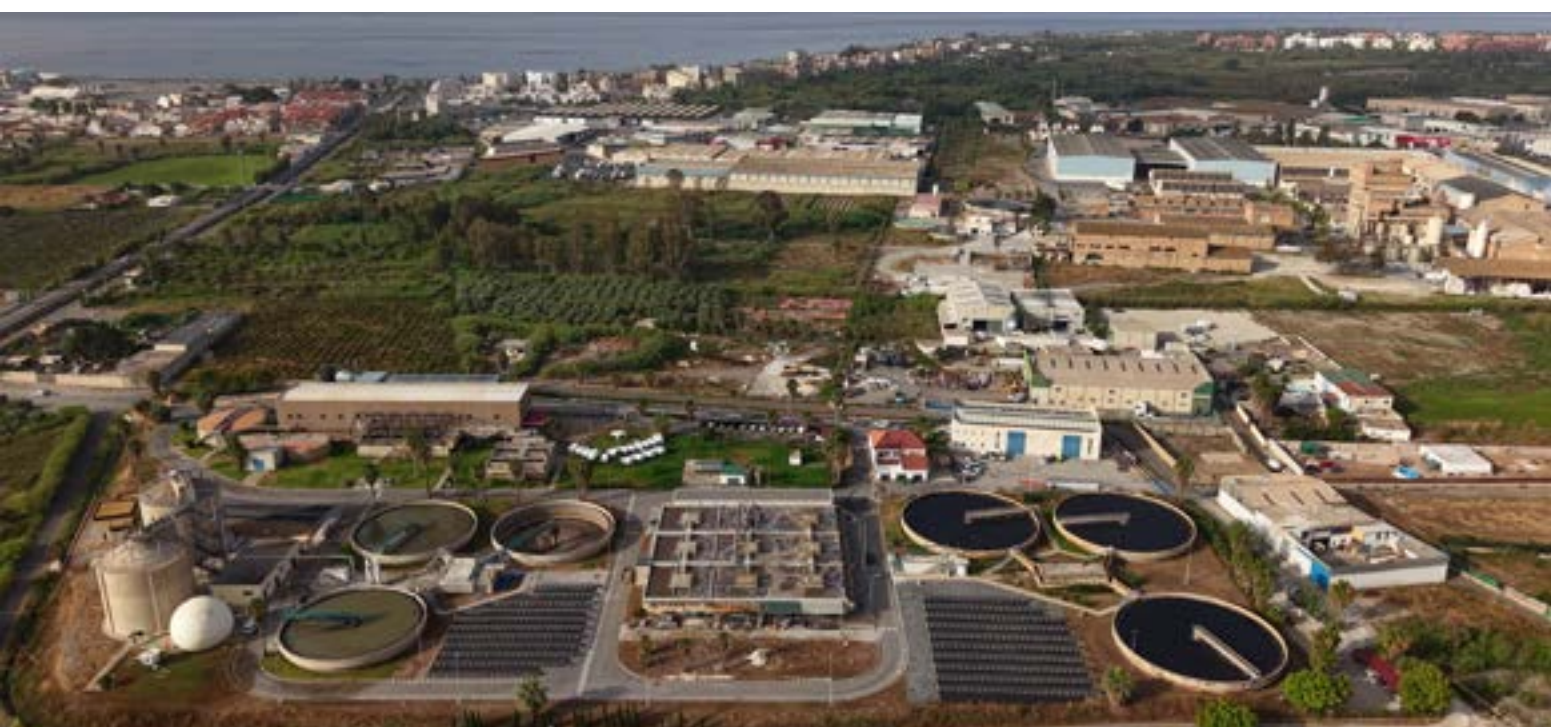
Vista aérea de Estación depuradora de Aguas Residuales Motril-Salobreña.
