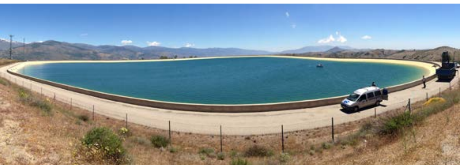
Balsa de Contraviesa, concebidas para reforzar el suministro de los municipios de la zona.
