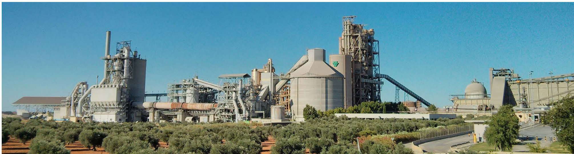
Panorámica centro productivo de cemento de El Alto, en Madrid.
