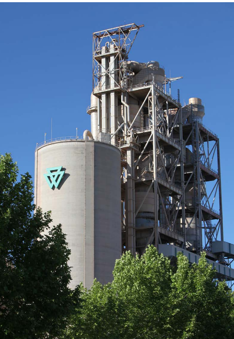
Torres de ciclones. Centro productivo de cemento de El Alto, en Madrid.
