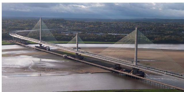
Puente Mersey, Reino Unido.
