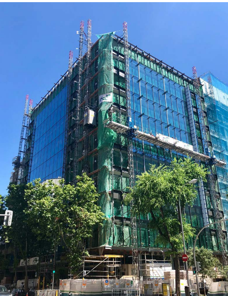
Rehabilitación edificio Gorbea 1, Madrid.
