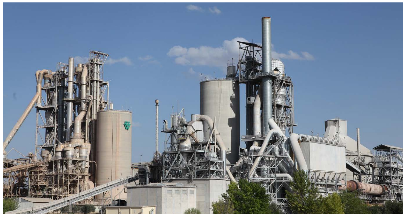
Línea de producción de cemento blanco. Centro productivo de cemento de El Alto, en Madrid.
