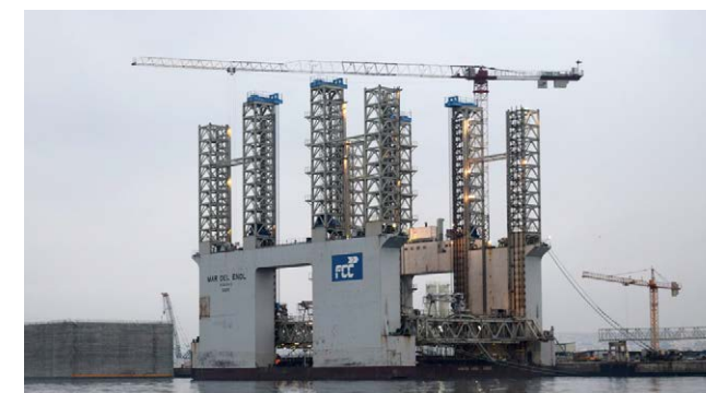
Dique Mar del Eno, España.
