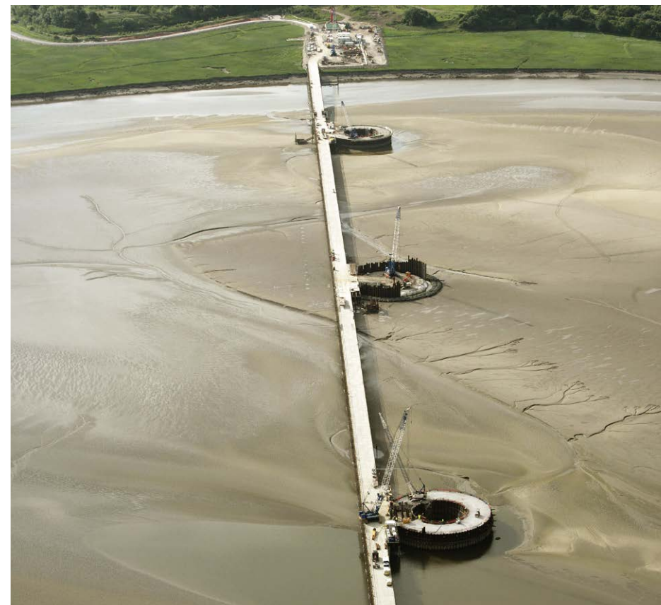
Puente de Mersey (Reino Unido).
